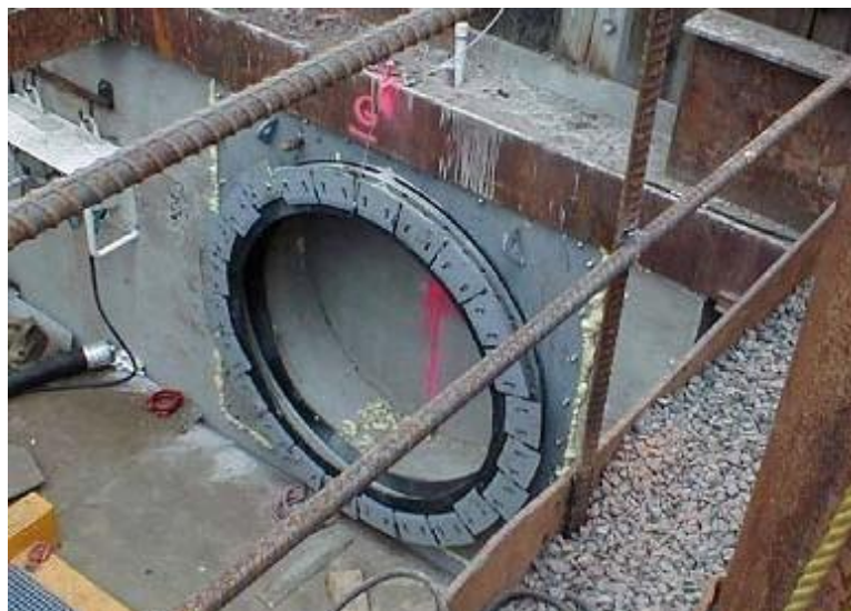
Fig 2-2 – Descrizione del metodo – Immagine di una stazione intermedia di spinta (da Herrenknecht website)
